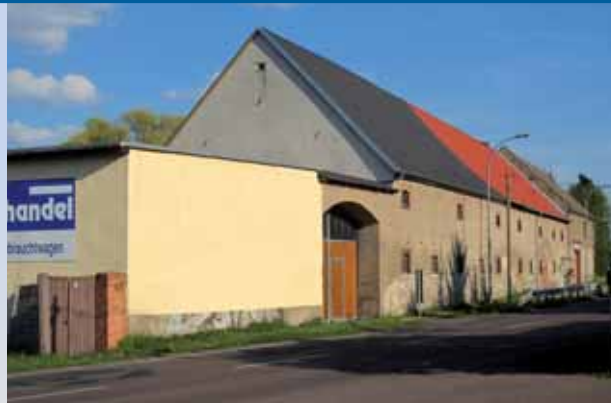
An der Straßenfront des früheren Henze-Hofes erkennt man noch heute die Aufteilung an mehrere Neubauern.
