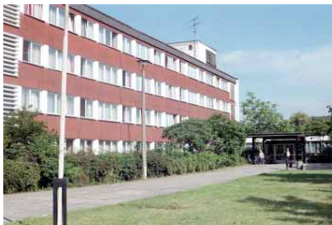
So sah das Pflegeheim im Böllberger Weg 150 vor den Umbau- und Sanierungsarbeiten aus.
